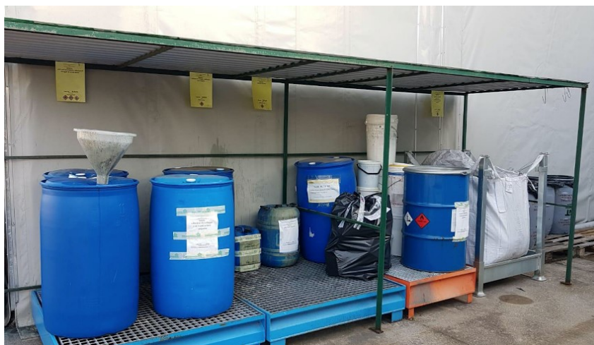
Fig.7 – Area di deposito temporaneo dei rifiuti pericolosi
