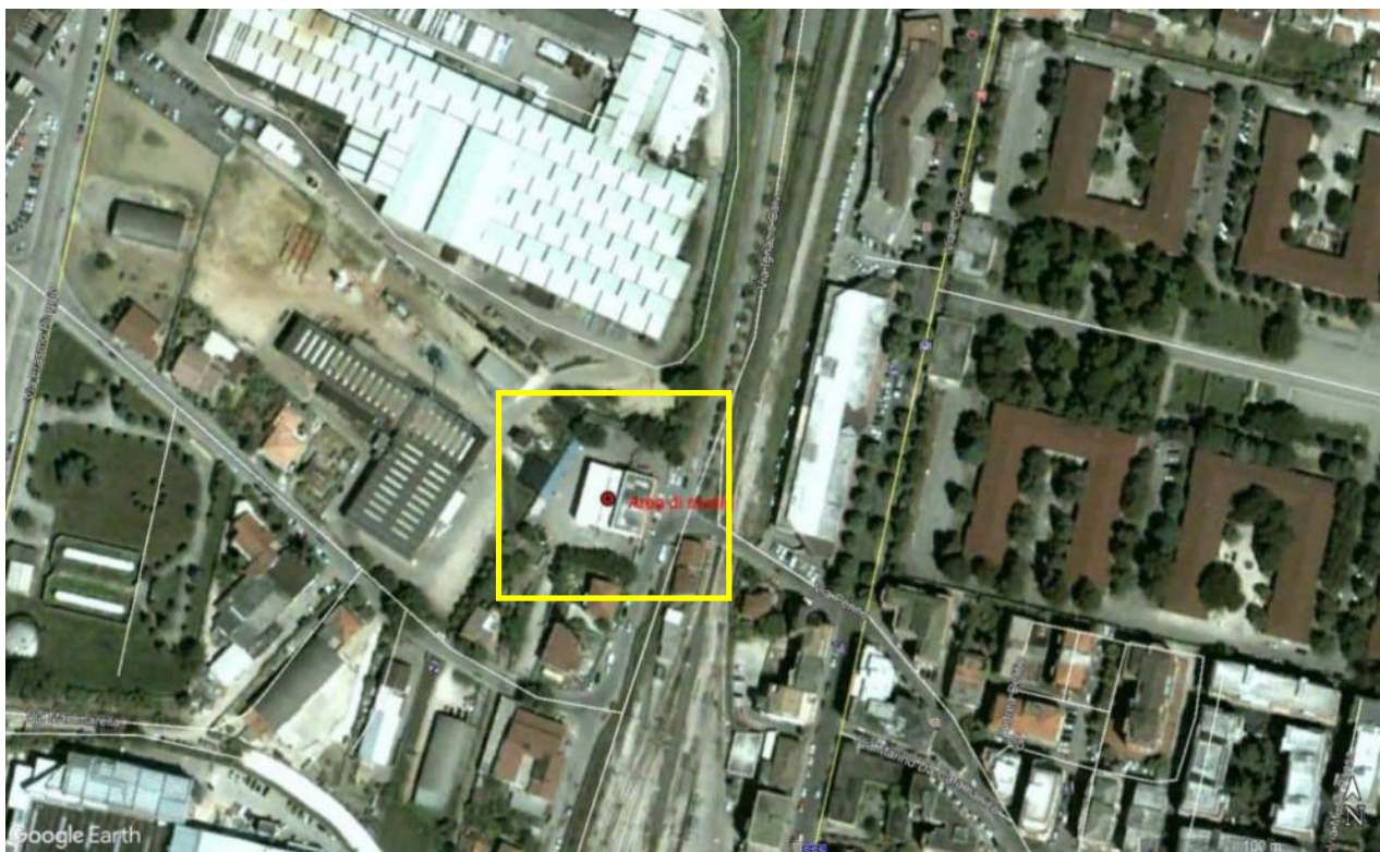
Figura 8 – Foto aerea Google Earth 2003
