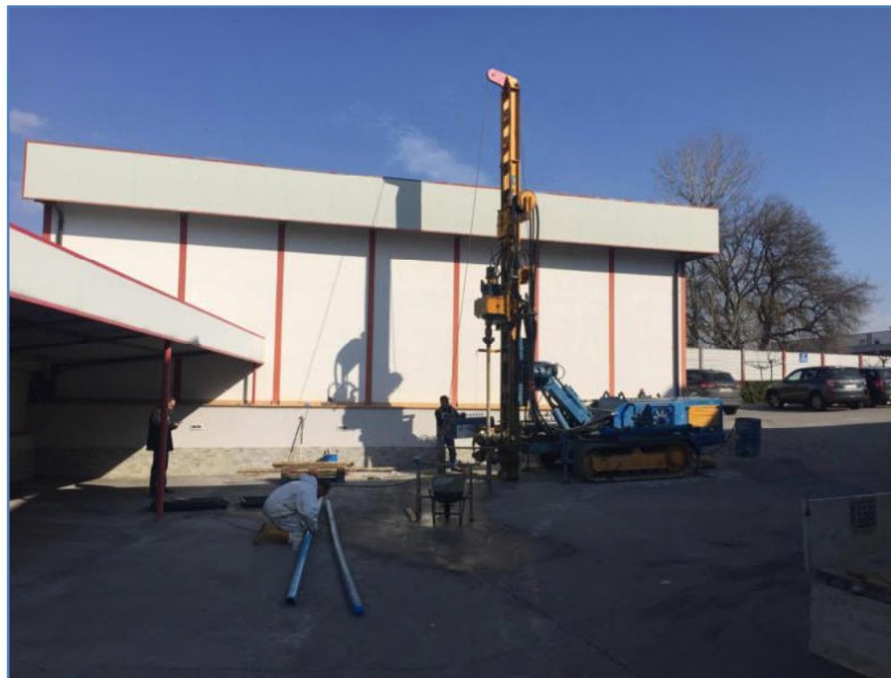
Installazione piezometro
