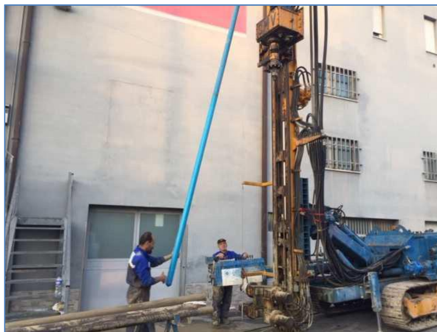
Installazione piezometro
