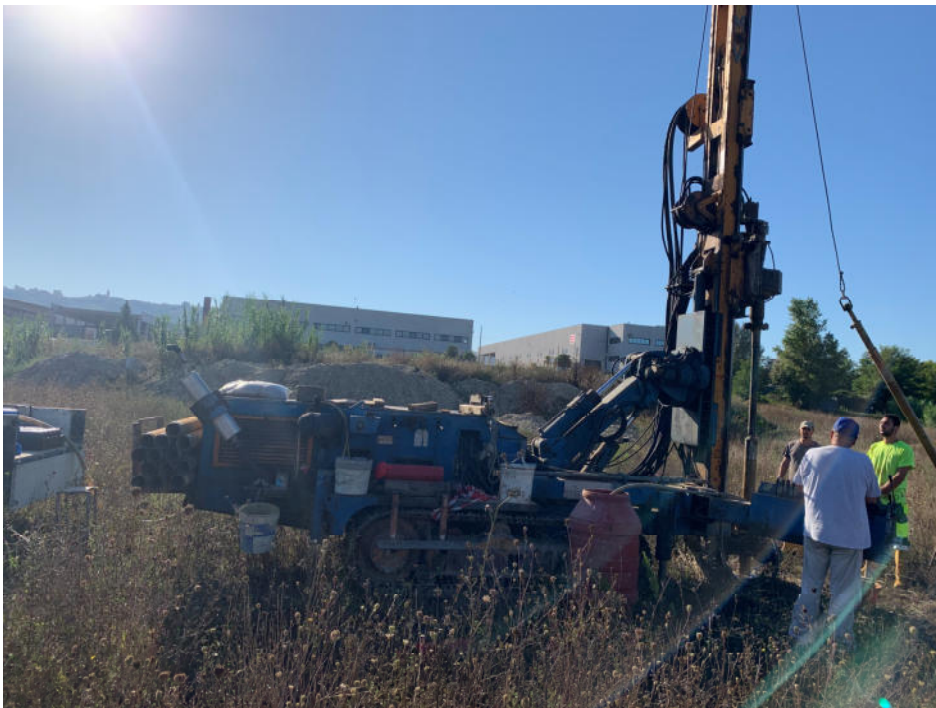
FOTO 4: Ubicazione piezometro PZD5 a valle del cumulo
