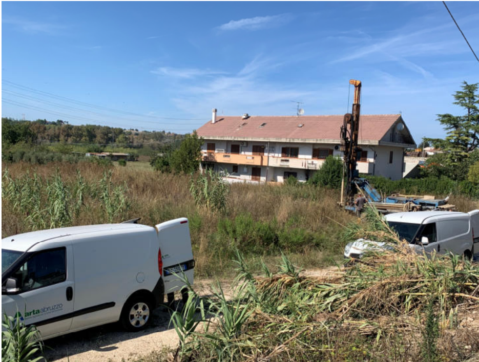
FOTO 5: Ubicazione piezometro PZD6 sul cumulo di materiale proveniente da terre e rocce da scavo.
