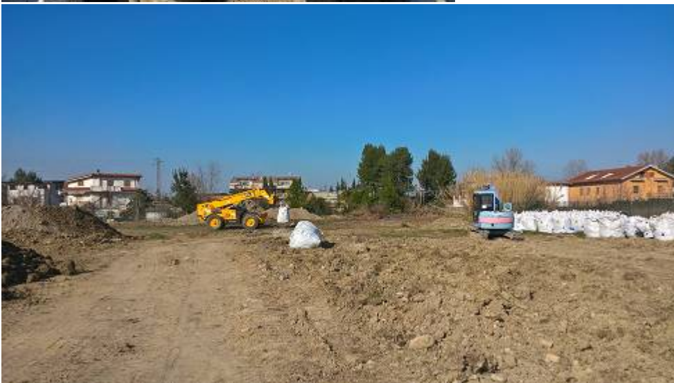
CER 170503* (terre e rocce contenenti sostanze pericolose)
