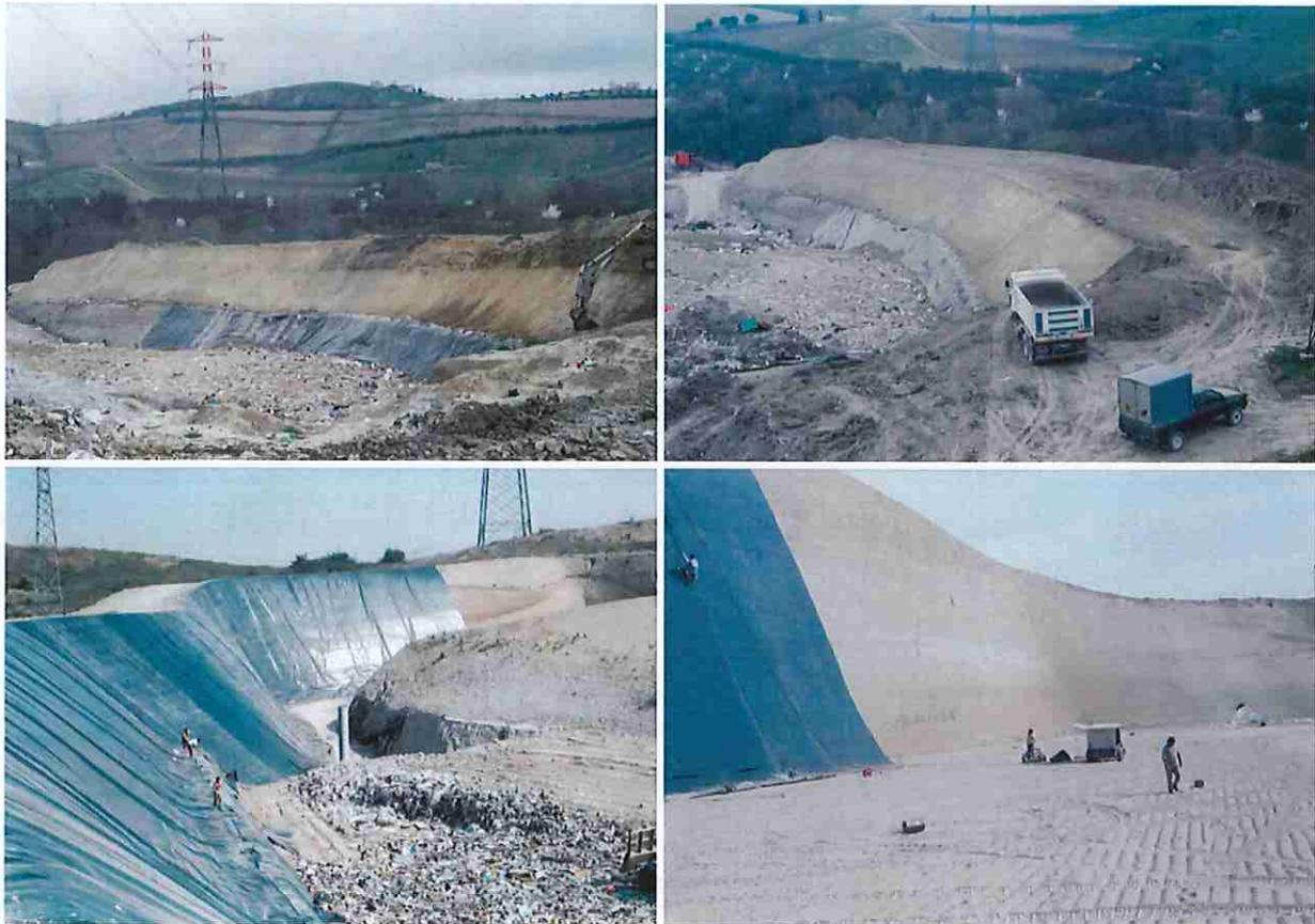
Fig. 1.2 – In alto: due fasi della coltivazione nella vasca più vecchia parzialmente protetta al bordo sud. In basso: immagini della posa in opera del telo HDPE nella vasca più recente.
