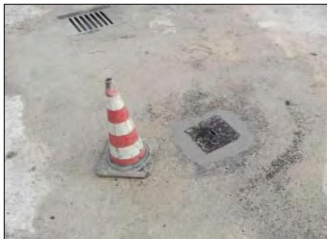
**Fig.9**– Pozzetto protezione strumentazione: pozzetto carrabile
