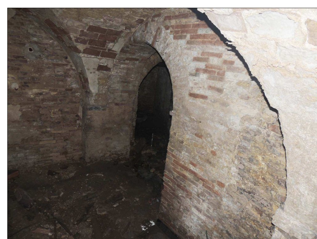
Vista collegamento Stanza 1 - corridoio
