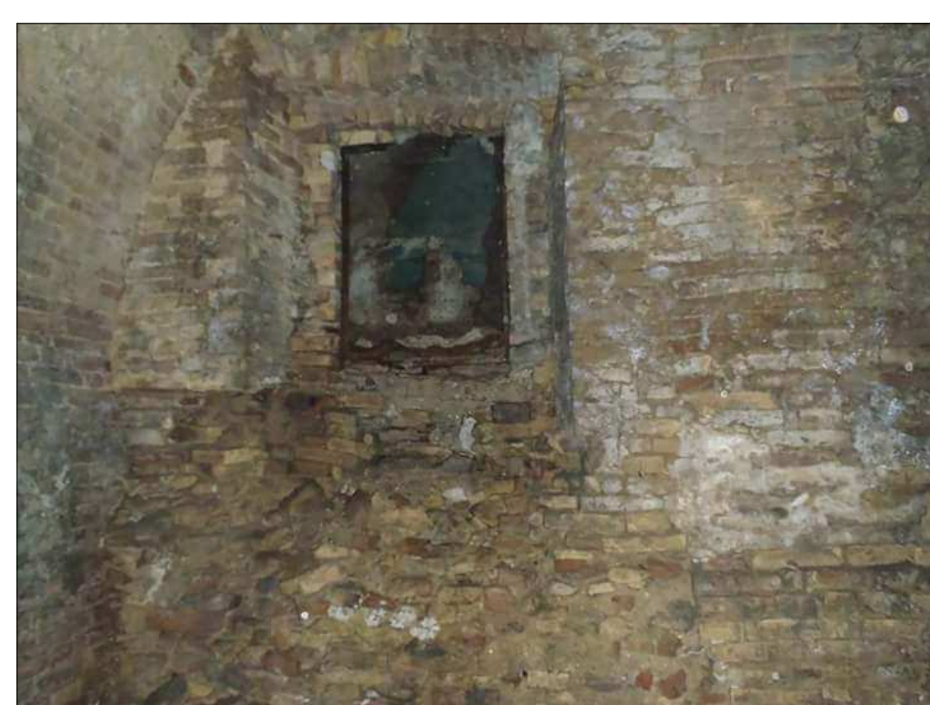
Vista nuovo accesso Stanza 2
